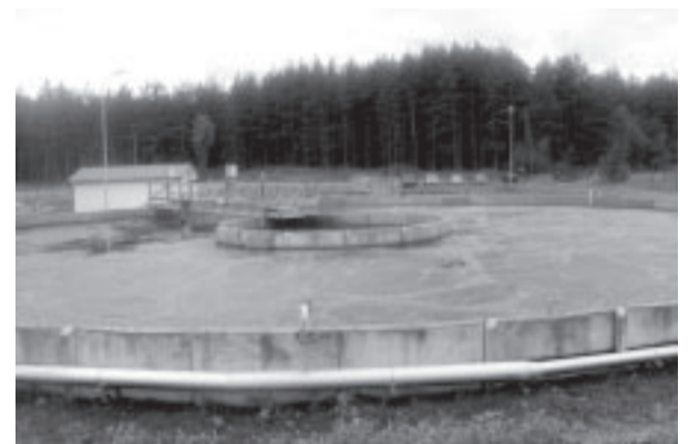
Новые реконструированные очистные сооружения сточных вод
