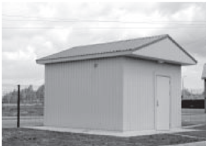
Насосная станция на ул. Лауку, 5/3
