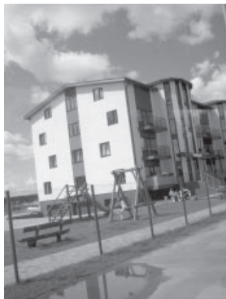
Daudzīvokļu māja Malienas ielā 2
